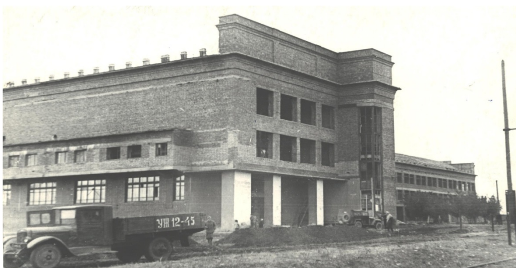
Строительство третьего учебного корпуса ДОННТУ
